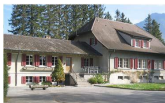
Centre de formation «Les Barges», Vouvry
